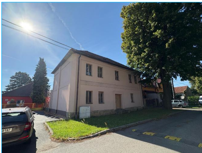
Obrázek 6 Budova fary – exteriér
