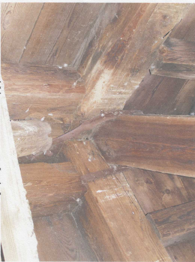
22. HORNÍ ČÁST LUCERNY - ZTUŽENÍ TRÁMENY
